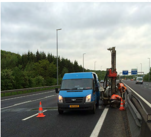
Forage de reconnaissance sur l'autoroute A3 pour l'étude d'un nouvel ouvrage d'art
